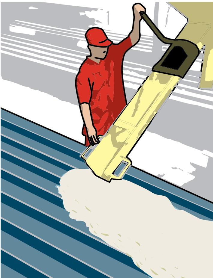
Lançamento do microconcreto (concreto com brita zero ou pedra meia) com fck 20 Mpa.
