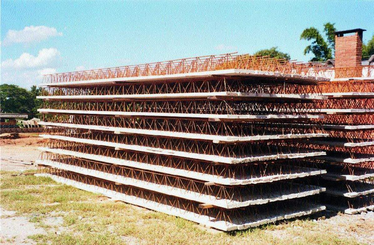
Na estocagem das peças, deve-se ter cuidado ao posicionar os sarrafos para os apoios. Devem ser colocados a cada 2,5 m ao longo do comprimento das peças.
