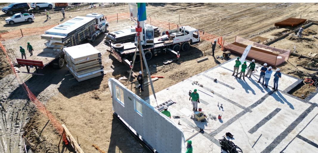
Montagem de painéis em canteiro. Foto: Tecverde, página Sistema Construtivo. [F8]
