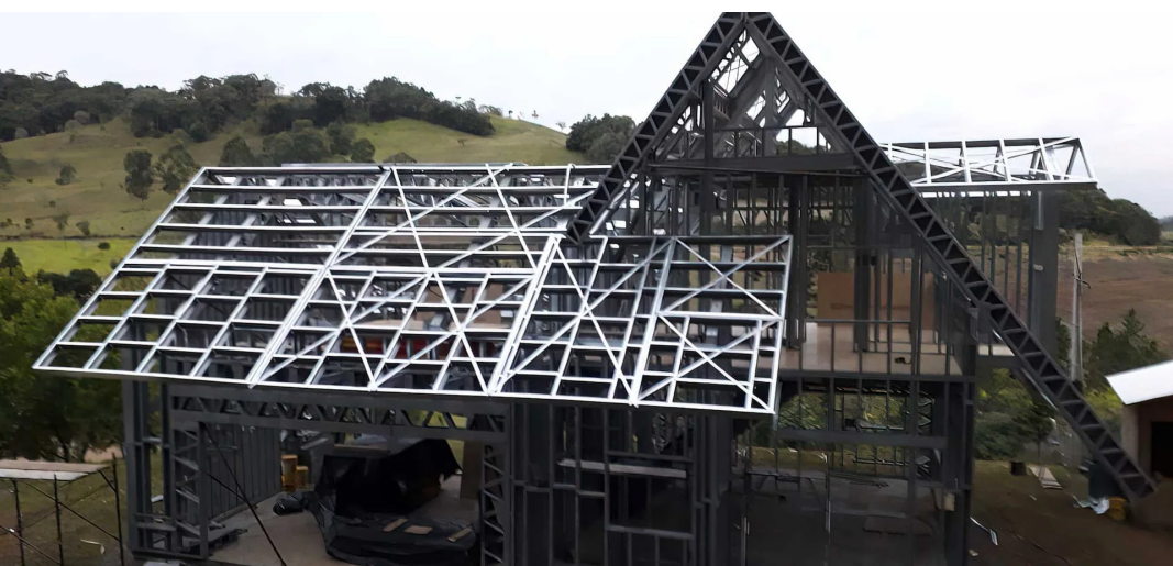
Chalé em São Lourenço do Oeste/SC durante a execução. Foto: Poli Steel. [F7]
