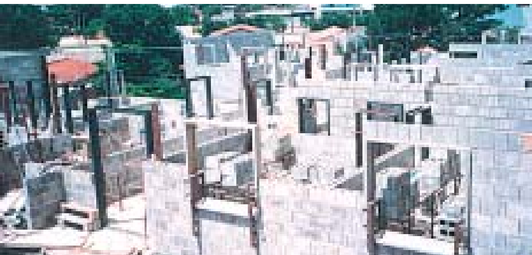
Elevação de alvenaria estrutural. Fonte: ABCP, Habitação 1.0, p. 26. [F2]
