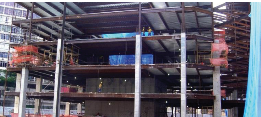
Pilares mistos em concretagem. Foto: Ricardo Werneck / Manual ABDI, p. 122. [F9]
