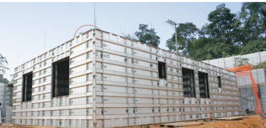
Sistema de paredes de concreto com fôrmas removíveis. Fonte: ABCP/ABESC/IBTS. [F3]
